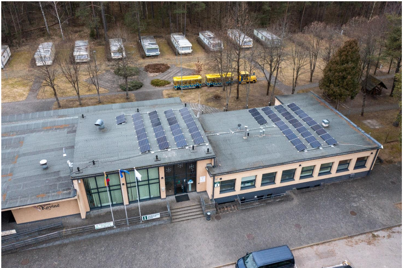
Saulės fotovoltinė elektrinė.
